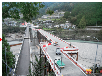
国道168号折立橋の復旧
