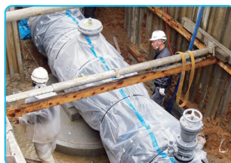
▲水を運ぶ送水管の工事
