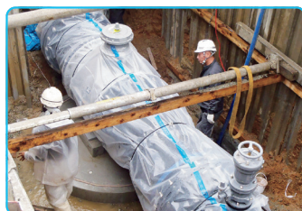
▲水を運ぶ送水管の工事
